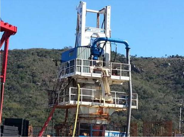
Ao final da escavação da estaca, foi realizada a limpeza do interior da mesma através do air lift, garantindo assim a boa qualidade da estaca.
